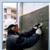
2. Se coloca el aislante directamente sobre la cara exterior de la fachada uniéndose mecánicamente con clavos de fijación (3 o 4 por m<sup>2</sup>) clavados una profundidad suficiente que no dañe el producto ni disminuya su espesor. No se recomienda fijar los paneles con clavos de fijación que tengan una corona de diámetro inferior a los 9 cm.
