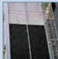
3. Se fijan los montantes a las patas de anclaje, y a éstos el enrastrelado. Debe preverse una cámara de aire continua de espesor superior a 3 cm entre el aislante y la protección externa.
